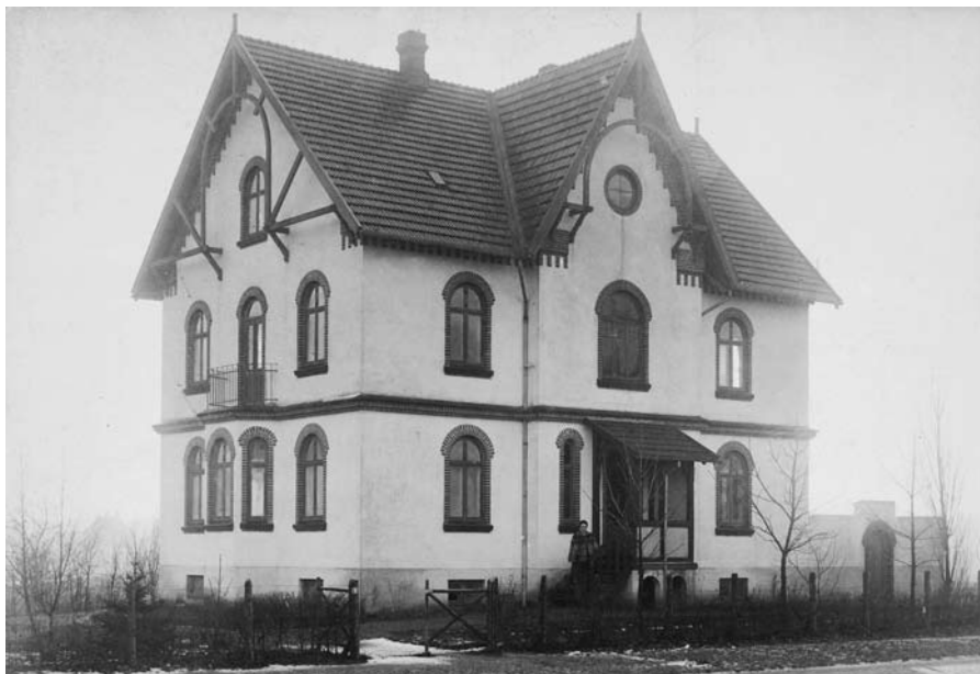
Ejendommen Bregnegårdsvej 5 i Charlottenlund, kaldet Villa Pax. Det er Louise Augustinus, som i vinteren 1910/11 har ladet sig fotografere foran huset. Billedet forærede hun til Rued Langgaard til "venlig Erindring om Efteraaret 1910 og d. 1ste Symphoni". (Kort- og billedafdelingen, Det Kongelige Bibliotek).
